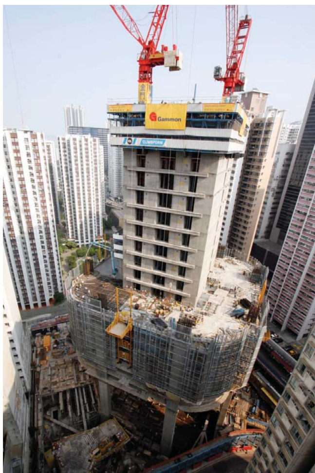
施工中的港岛东中心
