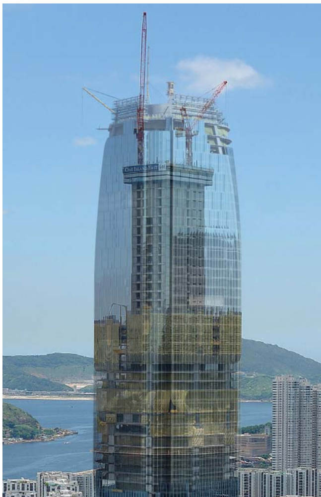
太古地产于兴建港岛东中心时采用“建筑资讯模型”
