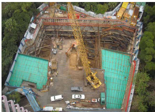
西灣臺項目工地設置隔音罩，減低對鄰近社區造成的噪音滋擾
