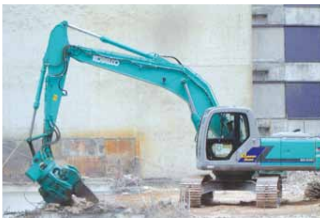
液压式破碎机可减少工地噪音。
